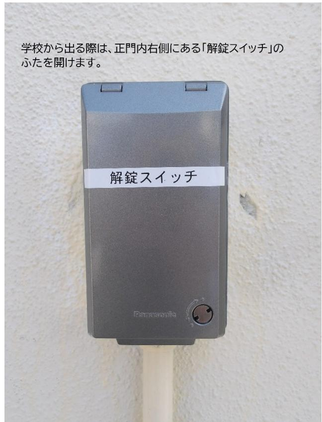
④ふたを開けて、「♪」ボタンを押すと、電子錠が解錠します。ボタンを押した方は解錠スイッチのふたを閉めて、門扉を開け、校外に出たら門扉を閉めます。
