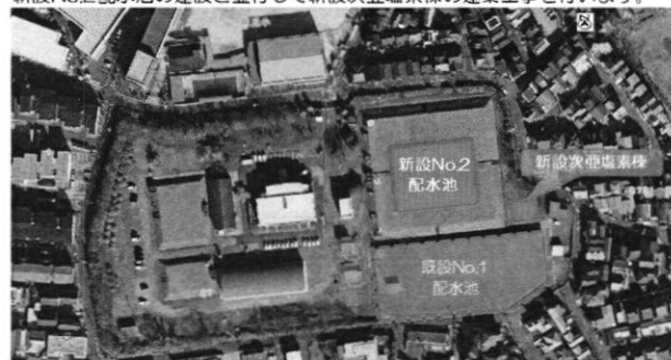
②既設No.2、3配水池等を撤去した後、新設のNo.2配水池を建設します。 新設No.2配水池の建設と並行して新設次亜塩素槽の建築工事を行います。
